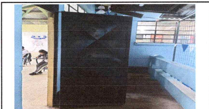
Foto 5: Mantenimiento de puertas, lijado, pulido, cepillado y aplicacion de pintura anticorrosiva a dos manos.
