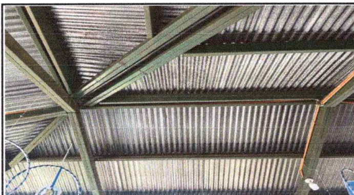
Foto 3: Mantenimiento de estructura metalica con lijado, pulido, cepillado y aplicacion de pintura anticorrosiva en techo de segundo nivel de centro educativo.
