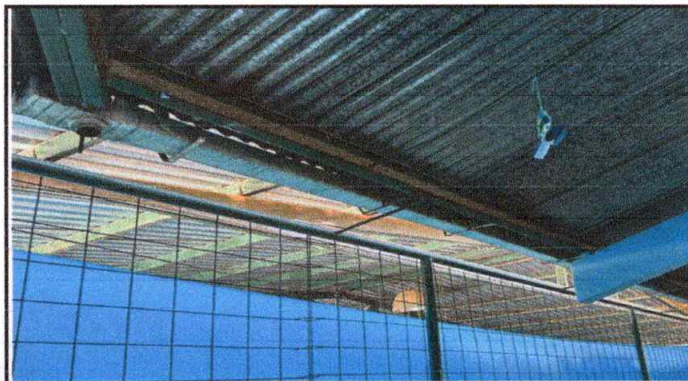
Foto 4: Sustrucción de canal de metal, bocatabos, bajadas de agua pluvial de PVC de 3", en segundo nivel de centro educativo.
